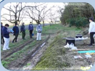
中小型獣用の防護柵設置の様子
