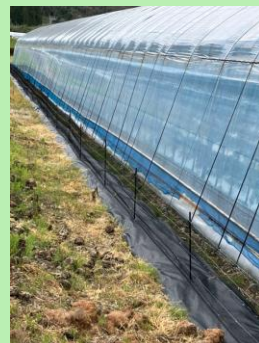
ネット設置後の様子
