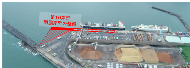
油津港の耐震岸壁整備
