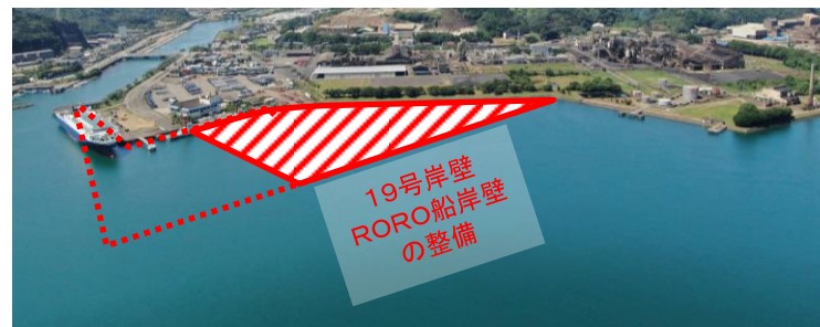
細島港19号岸壁整備
