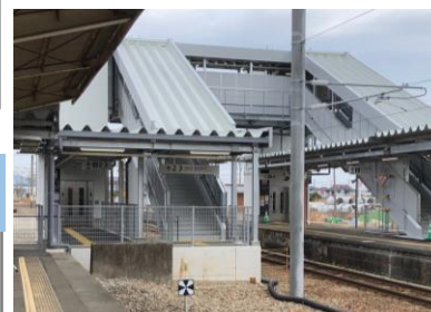
JR佐土原駅のバリアフリー化 （エレベーター付き跨線橋整備）
