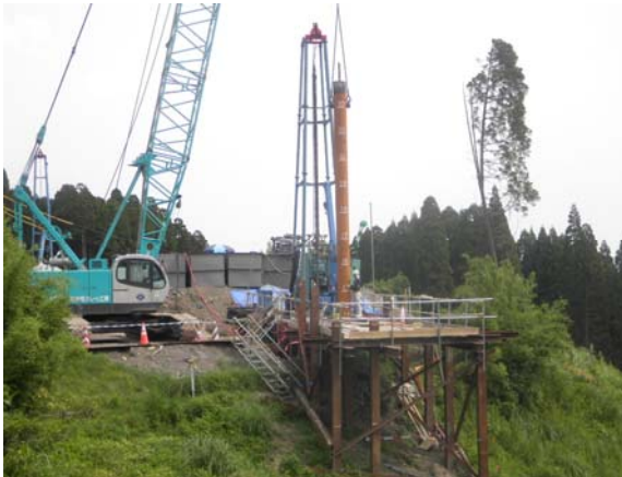
施工状況写真
