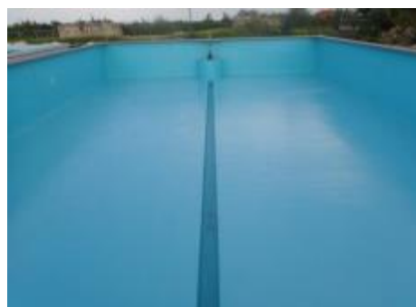
水槽内面FRP防食工事
