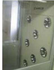
クリーンルーム内 エアシャワー
