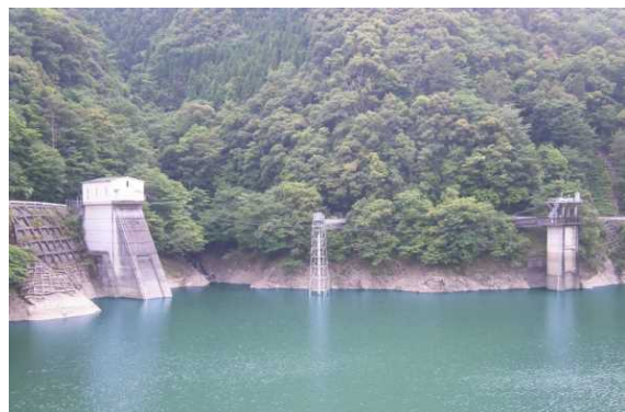
綾北ダム選択取水設備 (写真左)
