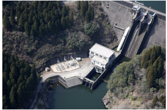
岩瀬川発電所
