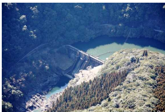
古賀根橋ダム
