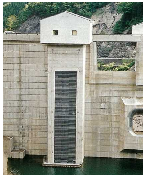
田代八重ダム選択取水設備
