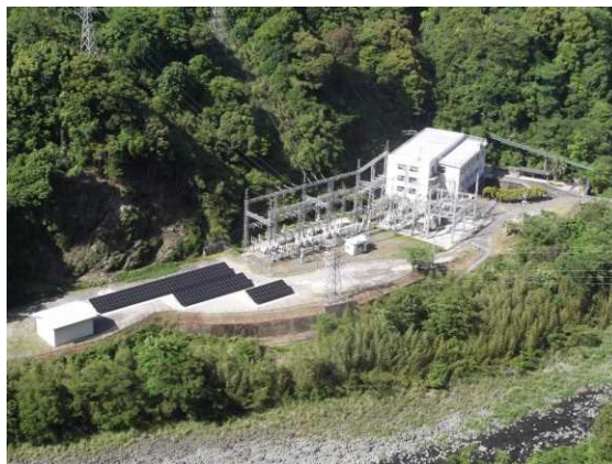
綾第二発電所
