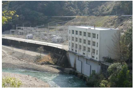
石河内第一発電所
