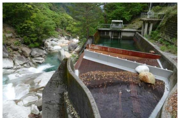
上祝子取水設備
