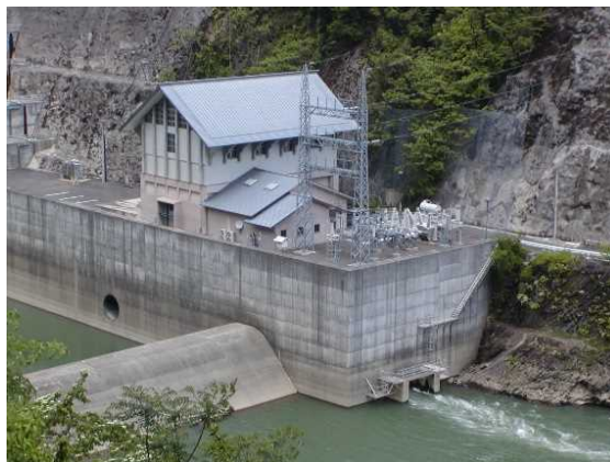
田代八重発電所
