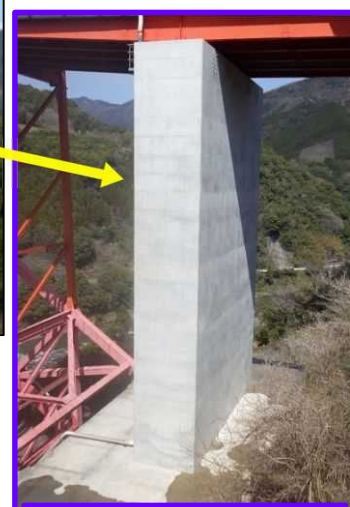
橋脚補強 コンクリート巻立
