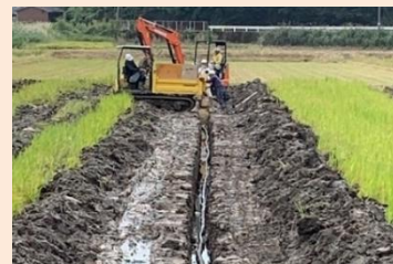
水田の暗渠排水整備
