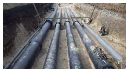
パイプライン整備
