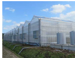
複合環境制御技術導入ハウスの整備
