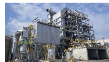
木質バイオマス発電所
