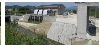
排水機場の更新整備
