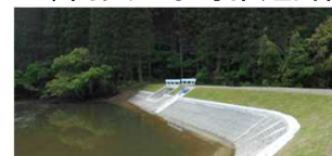
防災重点農業用ため池の整備
