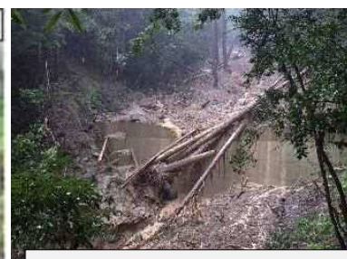
土砂及び流木等を捕捉した治山ダム
