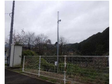
簡易型河川監視カメラの整備（管内21箇所）
