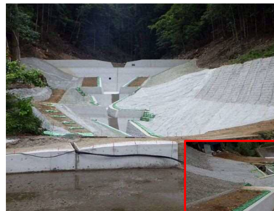
流木及び土砂を捕捉する治山ダムの施工
