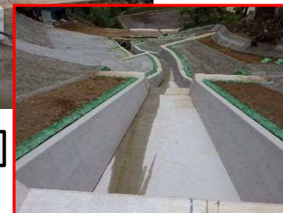
流木及び土砂を捕捉する治山ダムの施工
