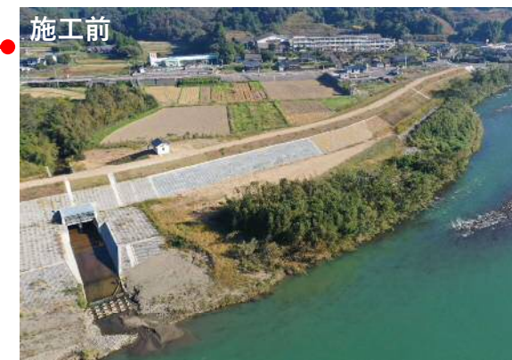
護岸施工箇所 (R2施工)
