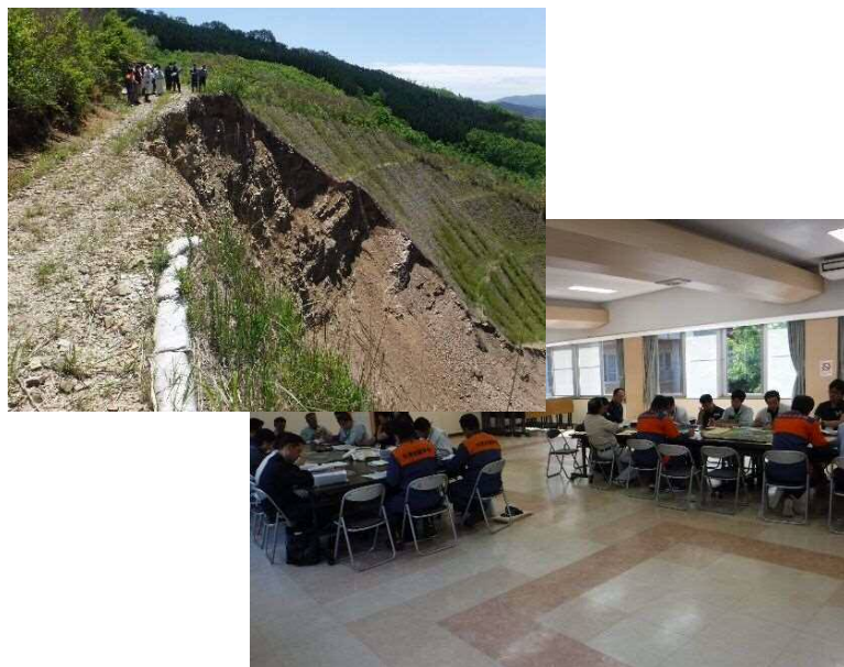
ハザードマップ等を活用した危険箇所調査の実施（危険箇所等の確認）
