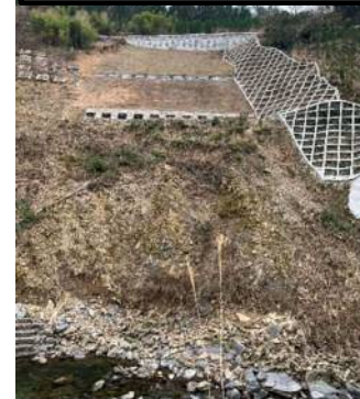
山腹工による土砂流出防止対策
