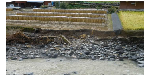
河川護岸と農地の被災状況
