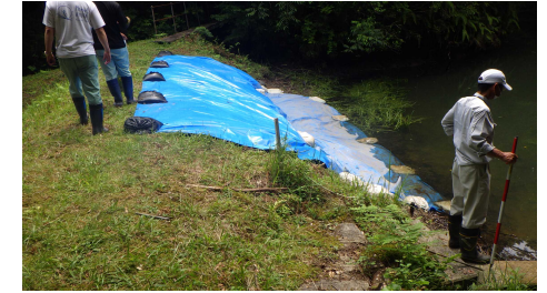
防災重点ため池の点検状況
