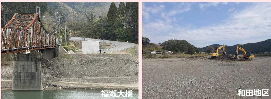
【宮崎県】耳川では、橋梁架替や宅地高上工事を進めるとともに、台風14号出水により堆積した土砂を掘削している。
