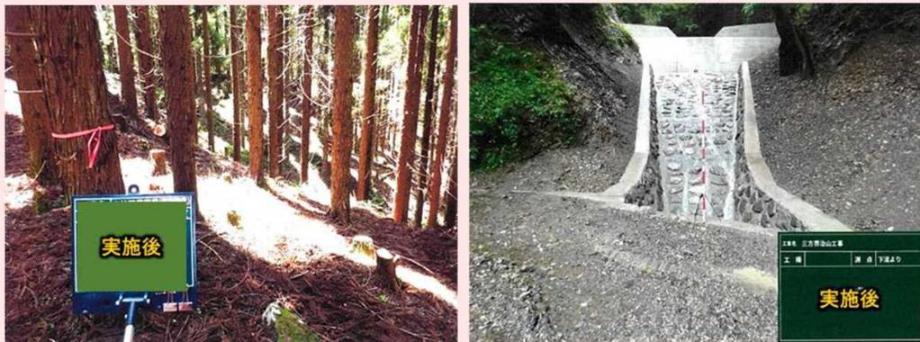
【宮崎北部森林管理署】土砂流出軽減のため、森林整備事業（間伐・下刈・植付）、谷止工及び流路工を設置した。
