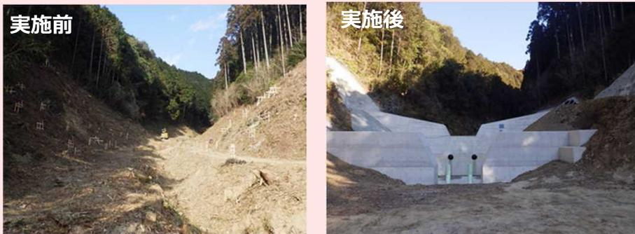
【宮崎県】西川内谷川において、土砂流出による災害から人命を守るため、砂防堰堤を整備中。
