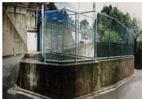
従前の防災調整池
