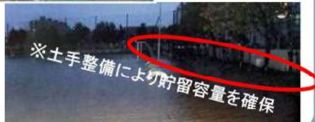
【校庭を活用した貯留施設】
