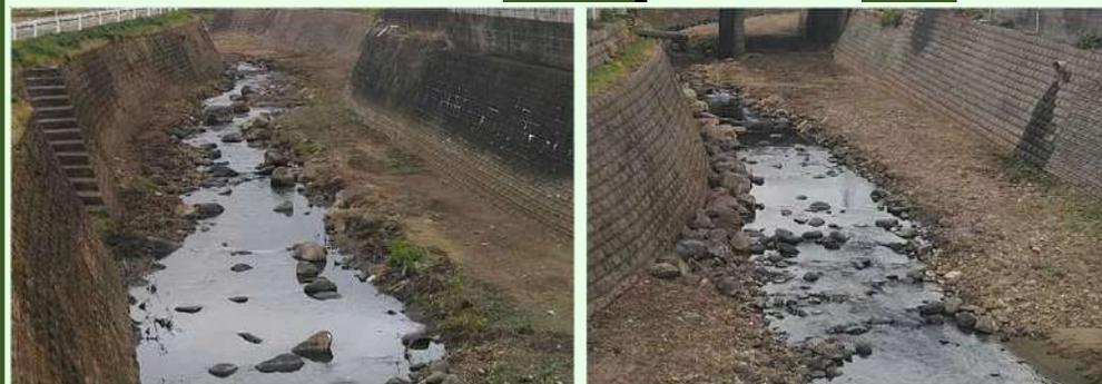
濡筋を蛇行させたり、玉石の設置等により、水生生物に配慮した工事を行った。
