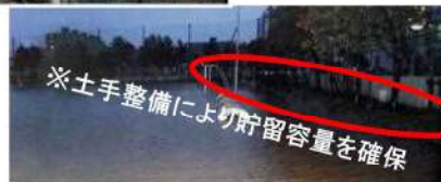
【校庭を活用した貯留施設】
