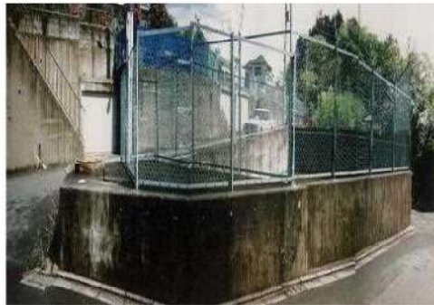
従前の防災調整池
