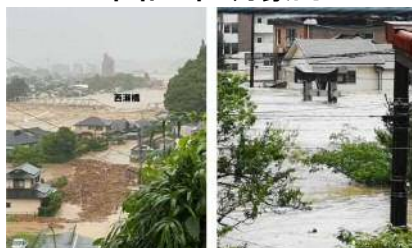
熊本県球磨川の浸水状況
