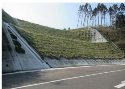
⑥植生基材吹付工による法面の緑化（串間市）
