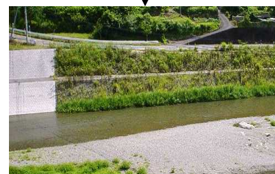
ポラカブル設置により緑化された護岸
