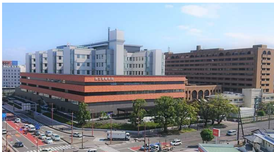
県立宮崎病院外観（右は旧病院）
