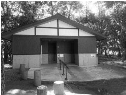
県有施設（トイレ）の改修
