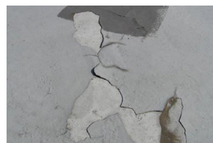
防水層の破損
