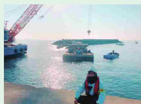
港湾工事はスケールが大きいです。天気その他に波浪にも注意しないといけません。
