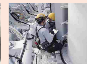
照明塔上部での工事や施工チェックはなかなか出来ない経験です。
