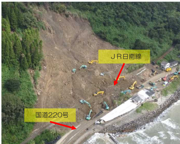
国土交通省による崩壊土砂の除去
