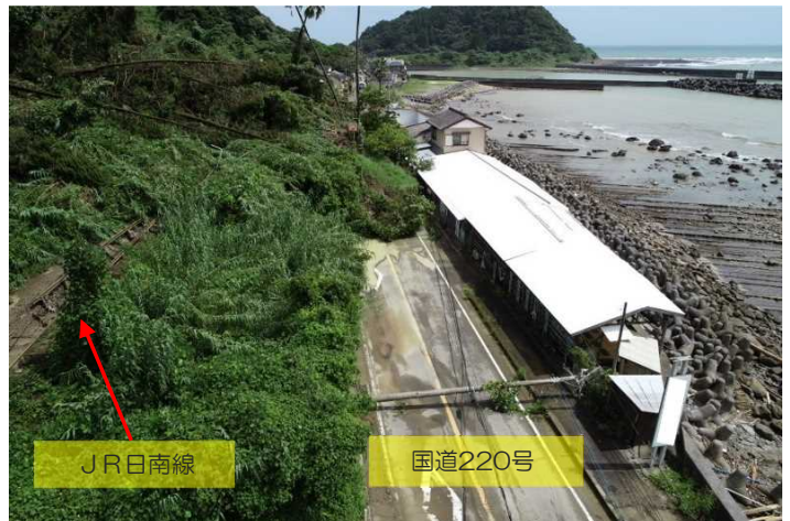
山腹崩壊による国道220号及びJR日南線の閉塞状況
