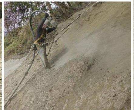
③ 仮設モルタル吹付
