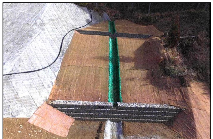
山腹工(宮崎市鏡州小平地区) 施工:溝口建設(株)
