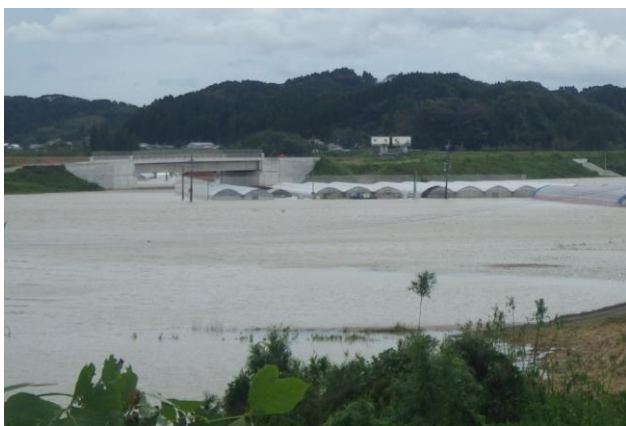
冠水により、施工中の宮王丸高架橋付近の一面の農地が湖と化した
