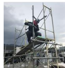
足場仮設工事
