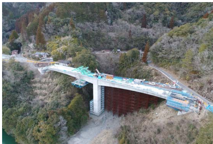
国道327号 佐土の谷工区
