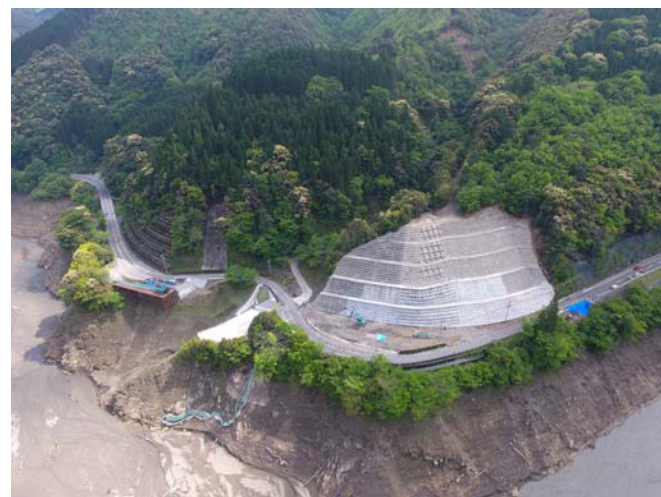
国道219号 越野尾工区
