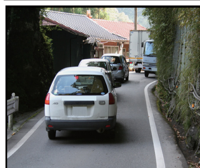
整備前 幅員が狭く、離合が困難な状況
