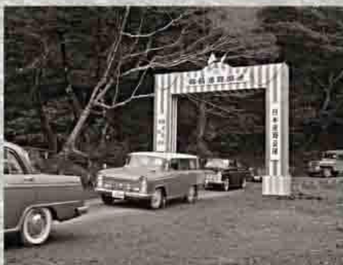
昭和35年霧島道路開通
