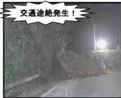
整備前 道路災害状況 平成27年6月20日発生 交通途絶：3日間
