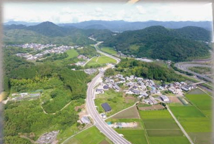
国道327号 永田工区
