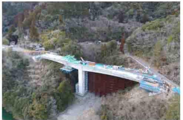
国道327号 佐土の谷工区
