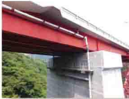
● 国道218号 千支大橋 (延岡市)
