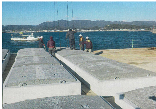
水産試験場が開発した海藻増殖機能付加型藻場礁を使用した藻場礁整備 （日向灘沿岸漁場 門川工区）
