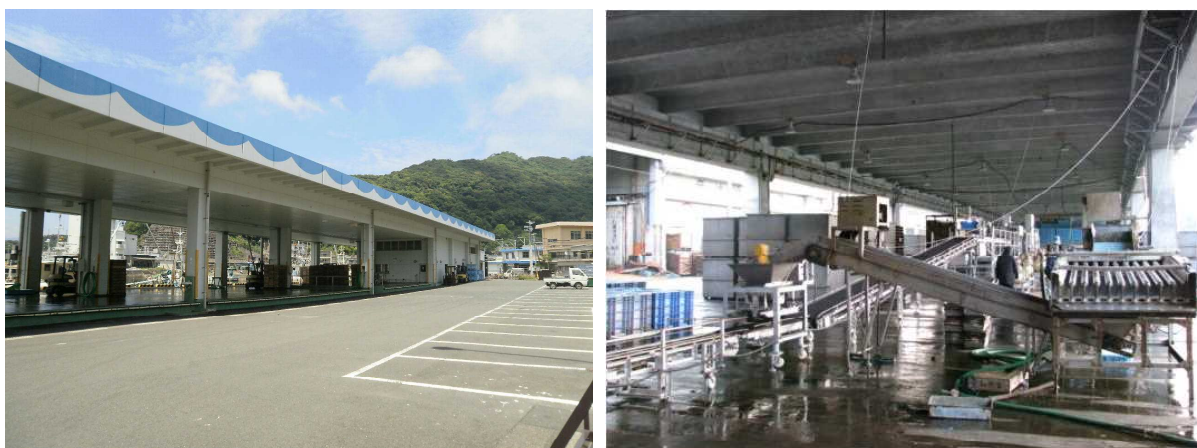
島浦町漁協の衛生管理型荷さばき施設と魚函積機
