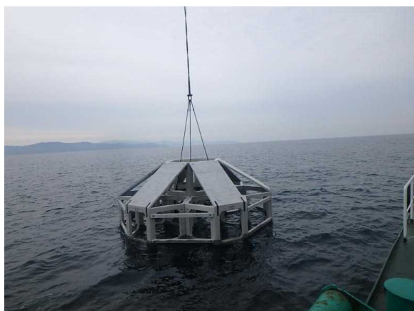
魚礁整備による既設魚礁の機能強化 （日向灘沿岸漁場 延岡工区）
