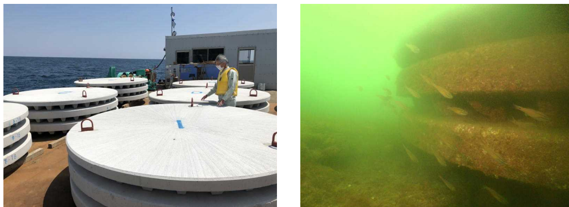
日南市沖に投入する前のコンクリートブロックとブロックに蟻集する魚類
