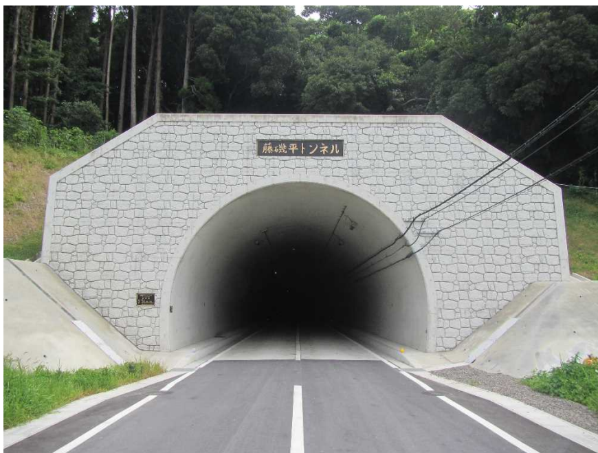
国道448号 藤磯平トンネル
