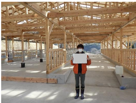
補助事業（畜舎建設）の完了検査
