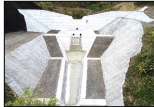
整備された砂防施設
