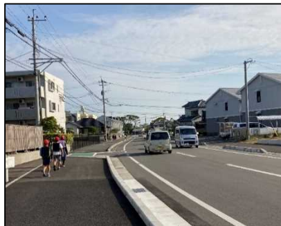
通学路の安全確保のための歩道整備 (勢田木崎線：宮崎市)
