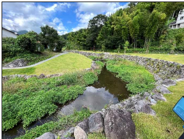
景観に配慮した水辺空間の整備 (神代川:高千穂町)
