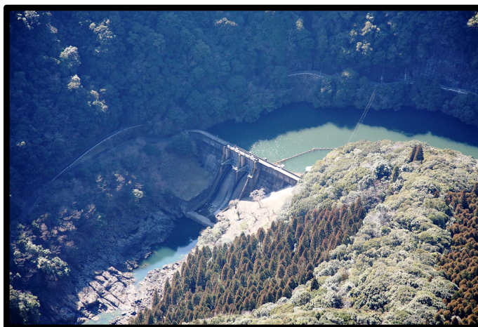
古賀根橋ダム
