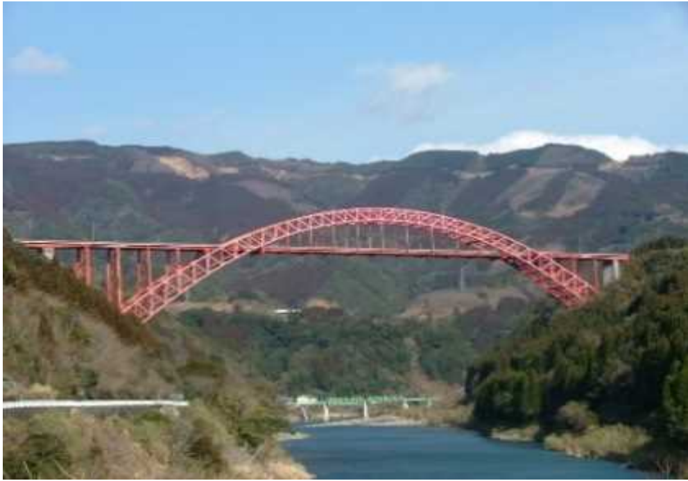
国道218号 干支大橋
