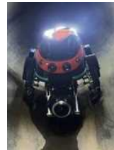
下水道管渠内調査多脚歩行式ロボット
