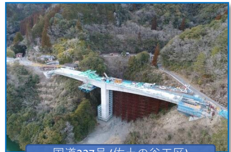
国道327号(佐土の谷工区)
