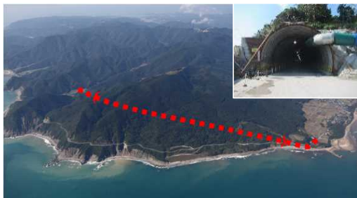
トンネル等整備中の国道448号石波工区
