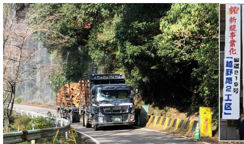
新規補助事業として採択された 国道219号 越野尾2工区
