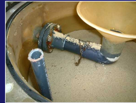
保健所立入時の濾過槽内
