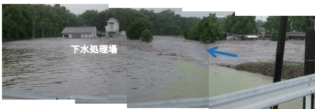
井手ノ上橋より下流側
