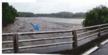
井手ノ上橋より上流側
