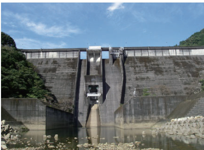
●設備更新 (放流設備改良工事)
