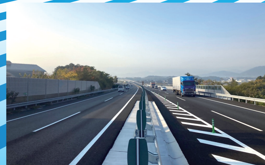
苅田北九州空港IC～行橋ICの一部区間 [4車線化完成]
