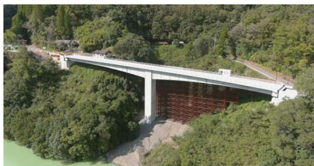
国道327号 佐土の谷工区
