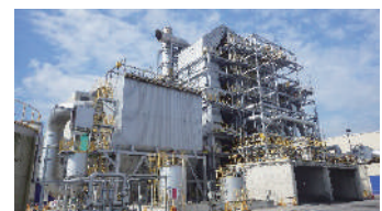
バイオマス発電所
