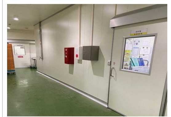
バリアフリーの作業場
